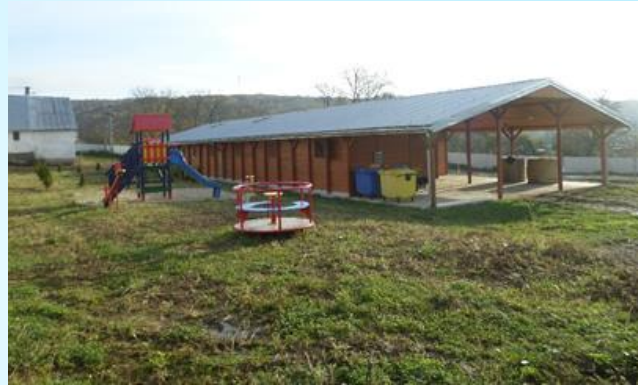
Fotografia po realizácii projektu; Zdroj: Archív AGRO MERNÍK, s.r.o.
