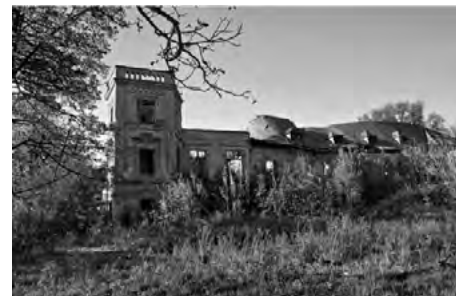
Veľký kaštieľ Apponyiovcov pred rekonštrukciou
