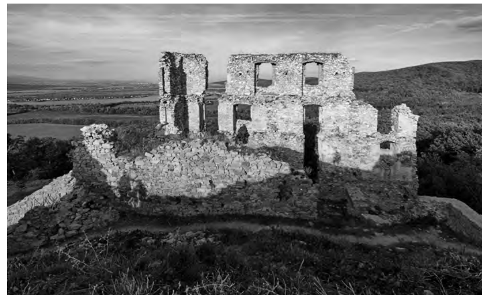
Ruiny neskororenesančného paláca na Oponickom hrade
